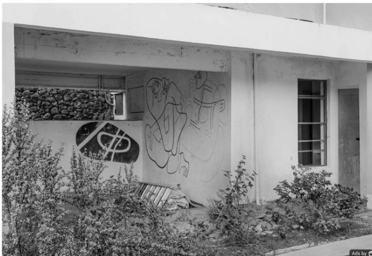
Casa E-1027, por Kasper Akhøj.
