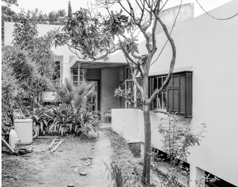
Parte del jardín de la villa, durante uno de los momentos de la restauración. KASPER AKHOJ
