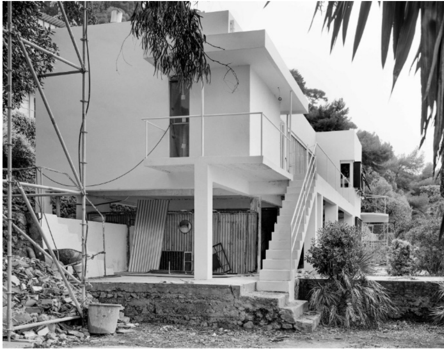
Casa E-1027, por Kasper Akhøj
