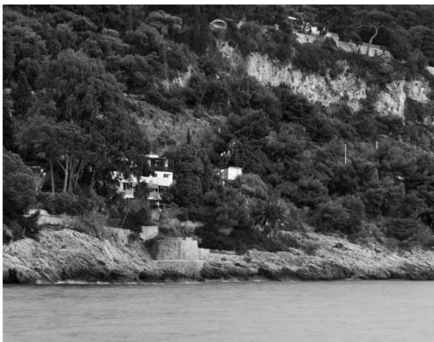
Casa E-1027, por Kasper Akhøj.
